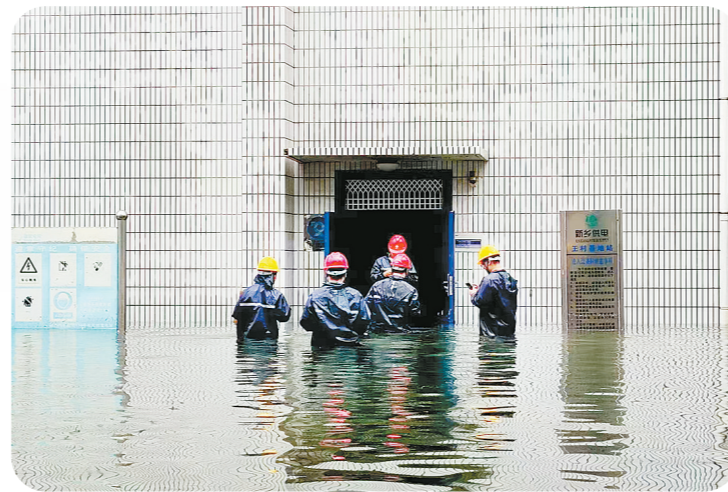
抗洪抢险勘察受灾变电站
