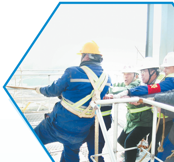
锅炉汽包吊装工作现场
