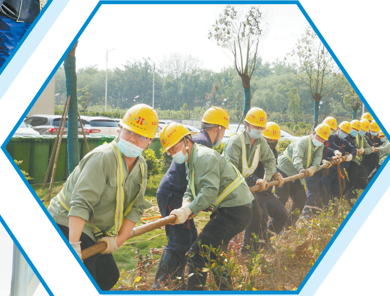
众人齐心协力铺设电缆
