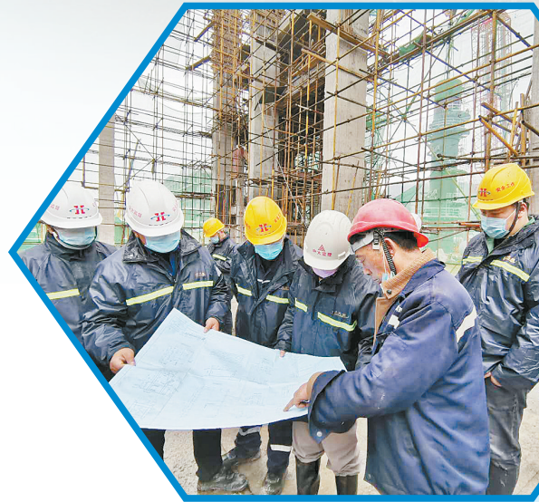
参建人员现场讨论施工细节
