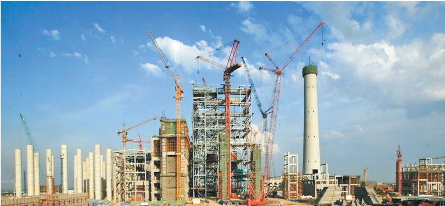
图中中新化工施工现场。
